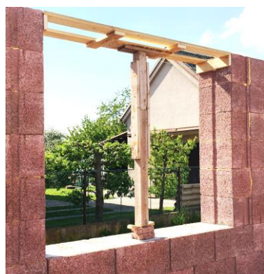
Ostění pomocí univerzálních tvárnic
