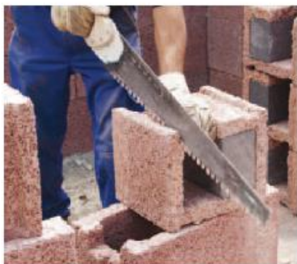
Vyříznutí drážek tvárnice vestavné do překladu
