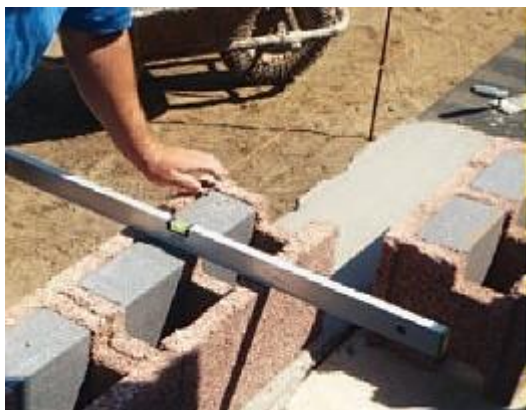
Zakládání první řady na zdící maltu
