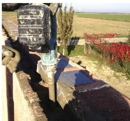
Zhuštění betonu pomocí ponorného vibrátoru
