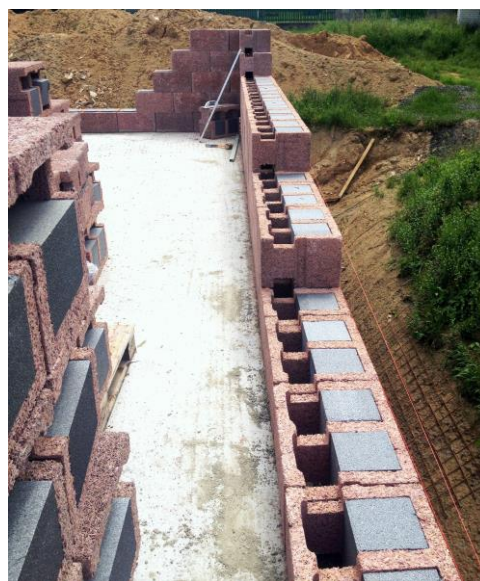
Průběh vyzdívání – vystavění rohu
