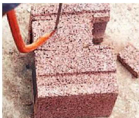
Řezání drážky (pilou, kotoučovou pilou)
