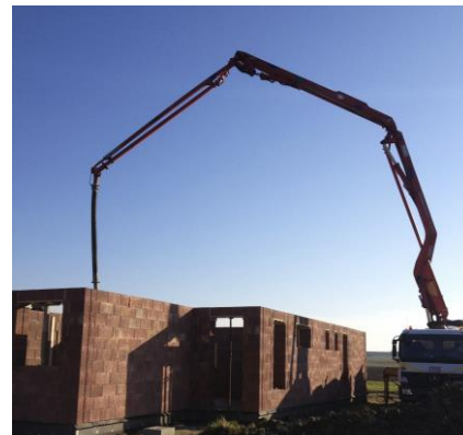
Betonování stavby čerpadlem
