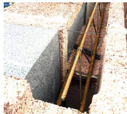
Vložená výztuž v překladu
