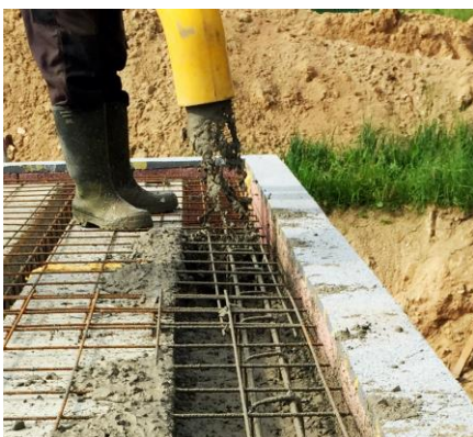
Betonování obvodových stěn spolu se stropem
