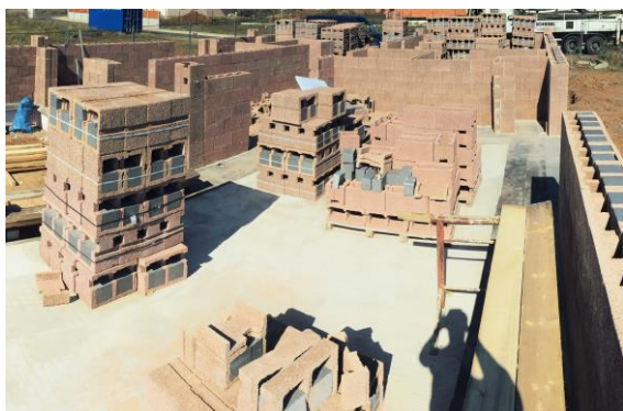
Stavba betonovaná po úsecích (cca po 1,5m)
