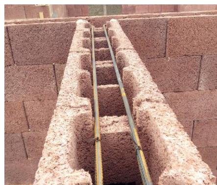
Větec u vnitřní nosné zdi
