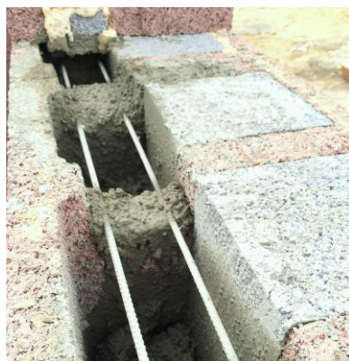
Vystužení parapetů (dva betonářské pruty)
