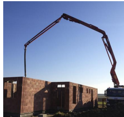
Betonování stavby čerpadlem
