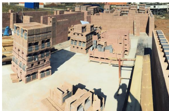
Stavba betonovaná po úsecích (cca po 1,5m)
