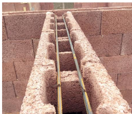
Věvec u vnitřní nosné zdi
