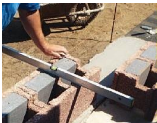
Zakládání první řady na zdící maltu
