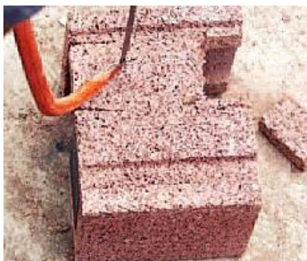
Řezání drážky (pilou, maflíkem)
