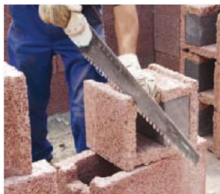
Vyříznutí drážek tvárnice vestavné do překladu
