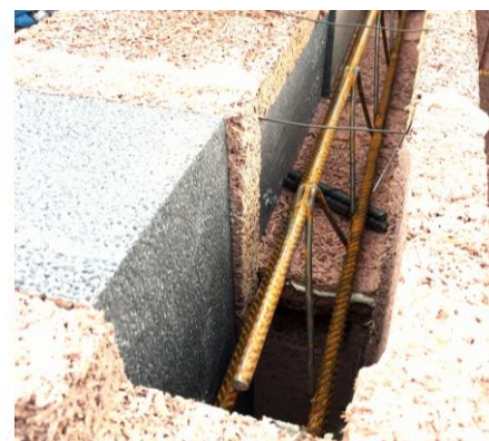
Vložená výztuž v překladu
