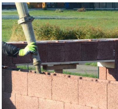
Betonování stěn Durisol pomocí čerpadla
