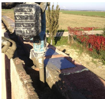
Zhuštění betonu pomocí ponorného vibrátoru
