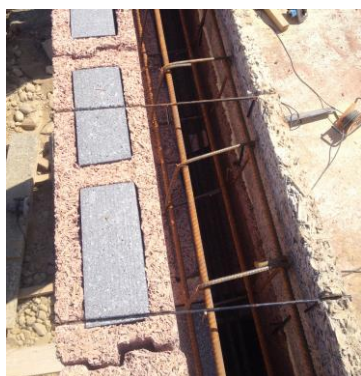
Věnec - věncová tvárnice a svázaná věncová výztuž
