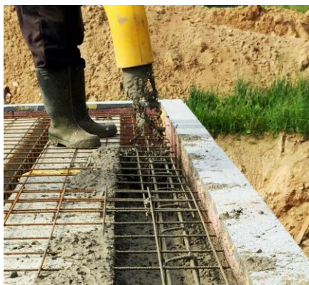
Betonování obvodových stěn spolu se stropem
