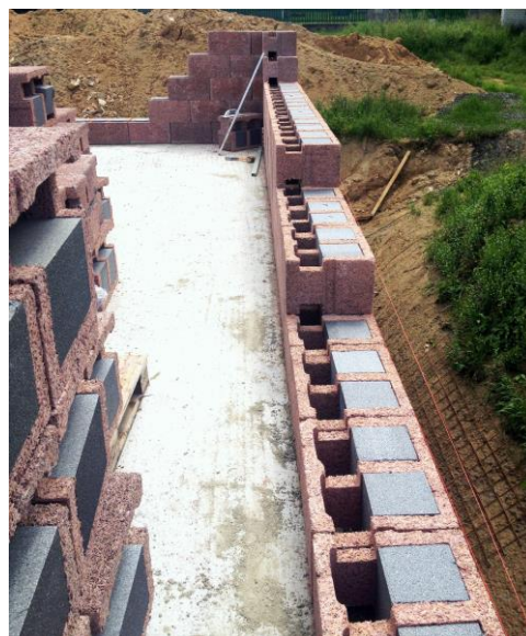
Průběh vyzdívání – vystavění rohu
