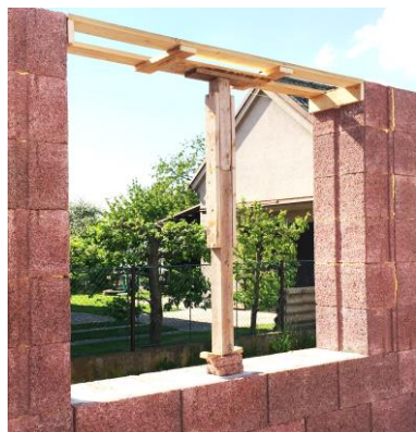
Ostění pomocí univerzálních tvárnic
